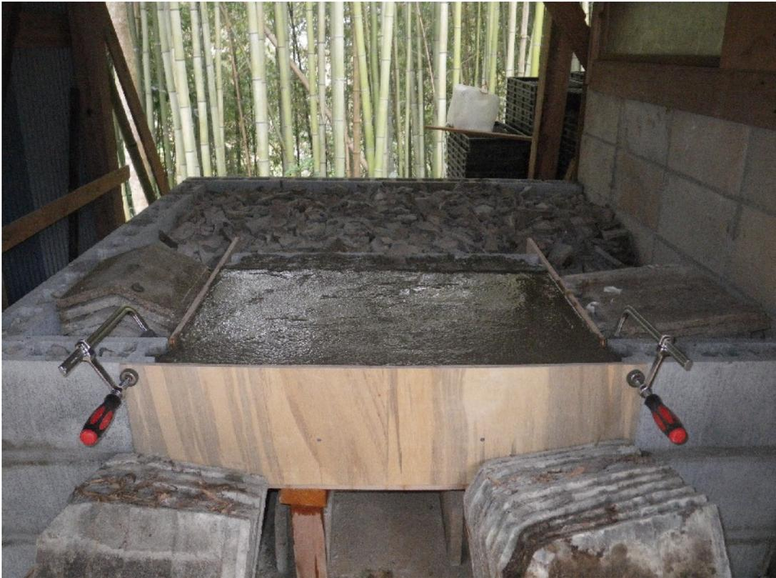
ピザ窯土台のアーチ部分にコンクリートを流し込みました。この部分だけでもドライ生コン(20kg入り袋)が4袋必要でした。……ということは、80kg+水分(約10kg)=計90kgの加重がかかっているんだ。大丈夫かしら？
