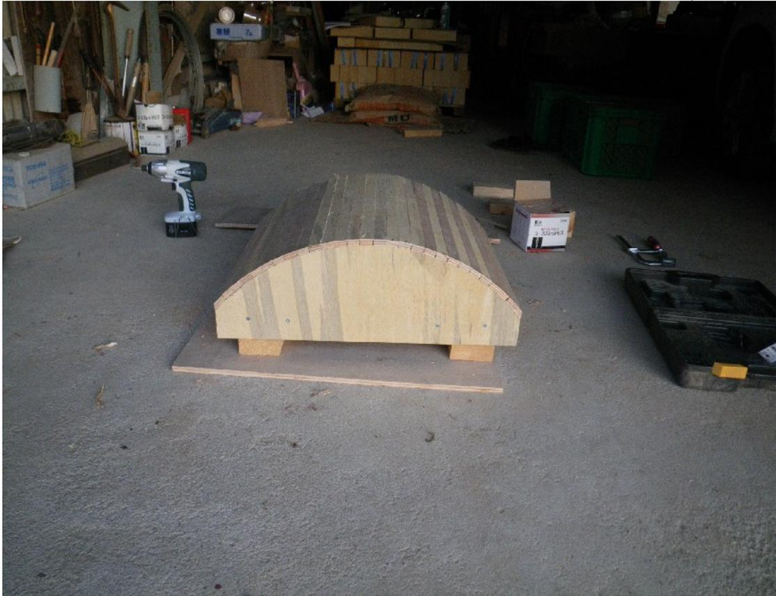
これはピザ窯用土台の型枠です。ピザ窯の土台の前面に薪を収納できるようにします。その上部にコンクリートでアーチを架けるために、型枠が必要なのです。
