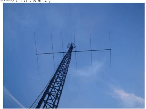
仮という意味は、アンテナをマストに取付けた位置が定位置よりも 3m 程低いところなので、このままではローテータが回せないのです。取り敢えず、上げるだけ上げて、SWR でも測ってみました。モノバンダーだからなのか、SWR は下図のように CW/RTTY/SSB バンドでほぼ 1.0 に近く、ダミーロードみたいです。
