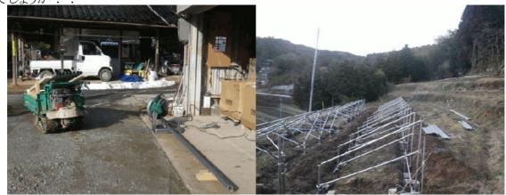
午後2時半頃帰宅すると晴れ間が広がっていたので、太陽光発電所の建設工事をしました。単管パイプを6本切断して、後段の縦桟のパイプを取り付けました。
