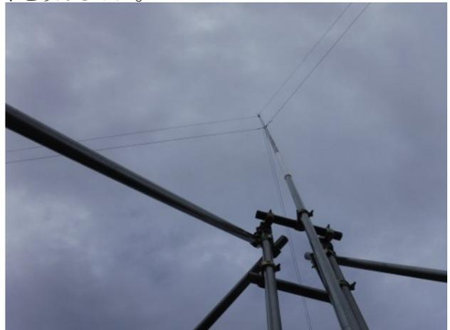
午後から80mバンド用バーチカルアンテナを建てました。先日から基礎部を作っていたので、AFA-75のエレメントに4mの単管パイプを継ぎ足したラジエータを起こして基礎部に取り付けました。垂直部の長さは15.2mで、AFA-75のローディングコイルが付いています。ローディングコイルの定数が不明なので、この状態で共振周波数が幾らなのか分かりません。後日、仮のラジアルを接続してアンテナアナライザーで測定する予定です。
