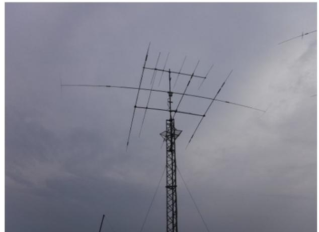
朝9時頃家を出て、ちょっと離れたローカル局のアンテナ工事のお手伝いに出かけました。これまで使われてた7/3.5用ロータリーダイポールを3.5~3.8用ロータリーダイポール(CD-78Jr)に乗せ替えました。CD-78Jrはリレーでコイルを切替えて3.5~3.8MHzの新しい周波数帯にも対応したものです。コイルを伸ばしたり縮めたりして整合するように調整します。短縮タイプなのでバンド幅はかなり狭いようです。
